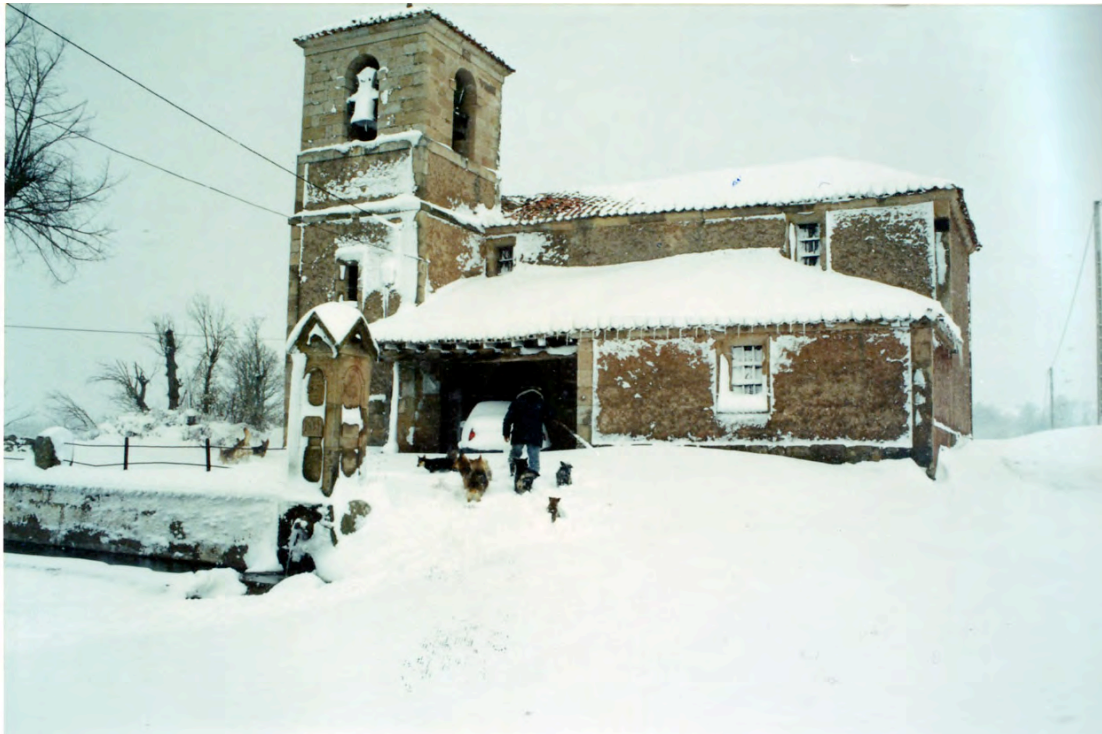
El pórtico de la iglesia, garaje improvisado para seis días de aislamiento.
